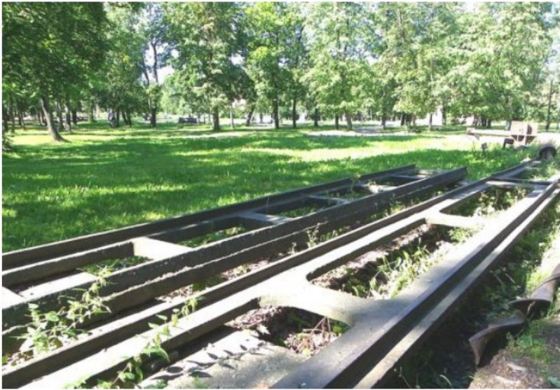
Рис.2. Чугунный рельсы с U-образной колеей в виде желоба
